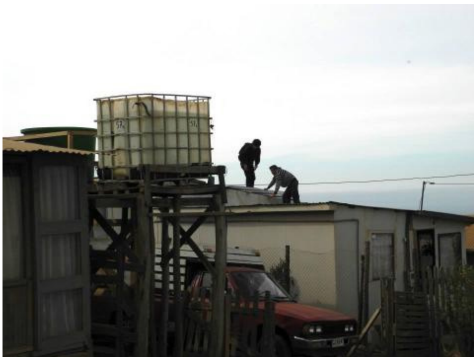
图27. 在Mariposa山安装天线。
